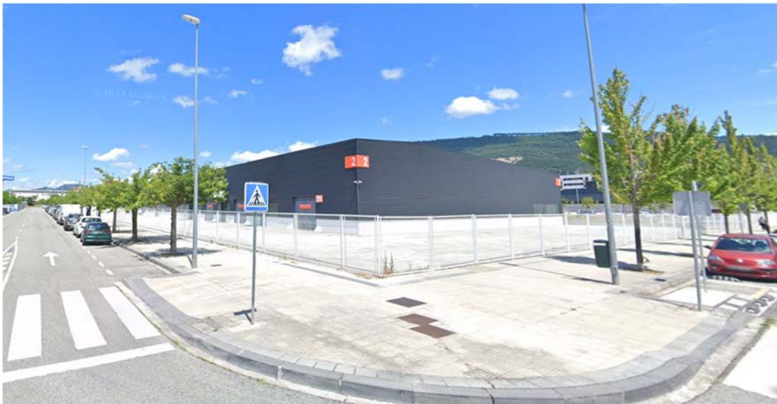
Detalle de fachadas de nave a calle trasera.
