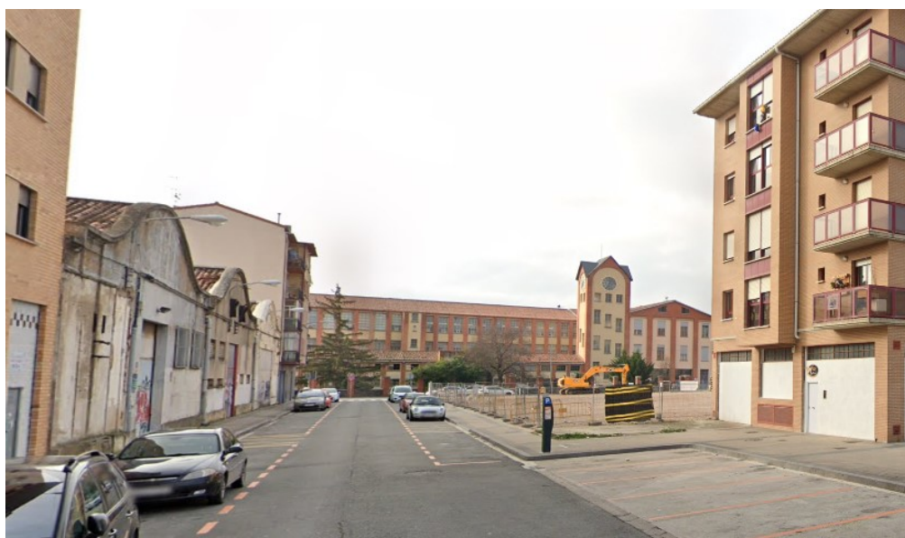
Travesía Artica. En la actualidad la Unidad A-5 se encuentra en fase de construcción. Al fondo edificio IWER.
