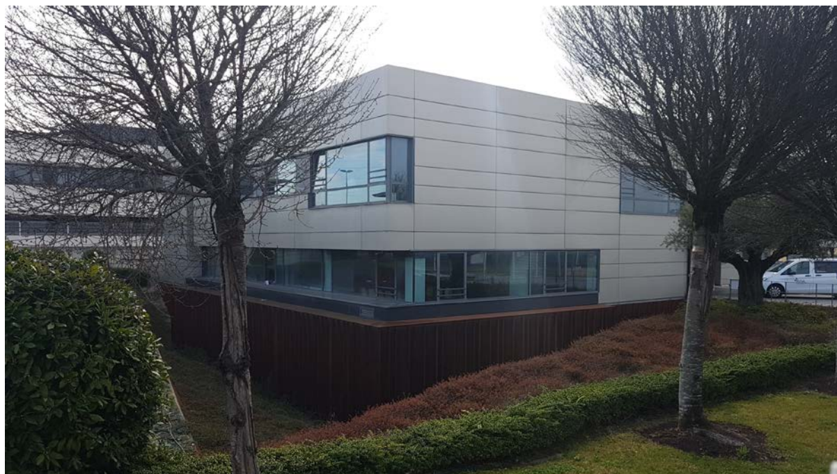
Sótano Fachada Norte - Oeste
