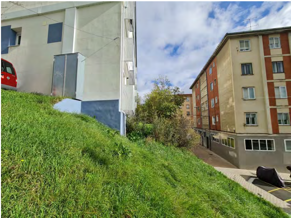
Abajo. ESPACIO AJARDINADO FACHADA SUR CON FUERTE PENDIENTE NO APTO PARA TRANSITO PEATONAL
