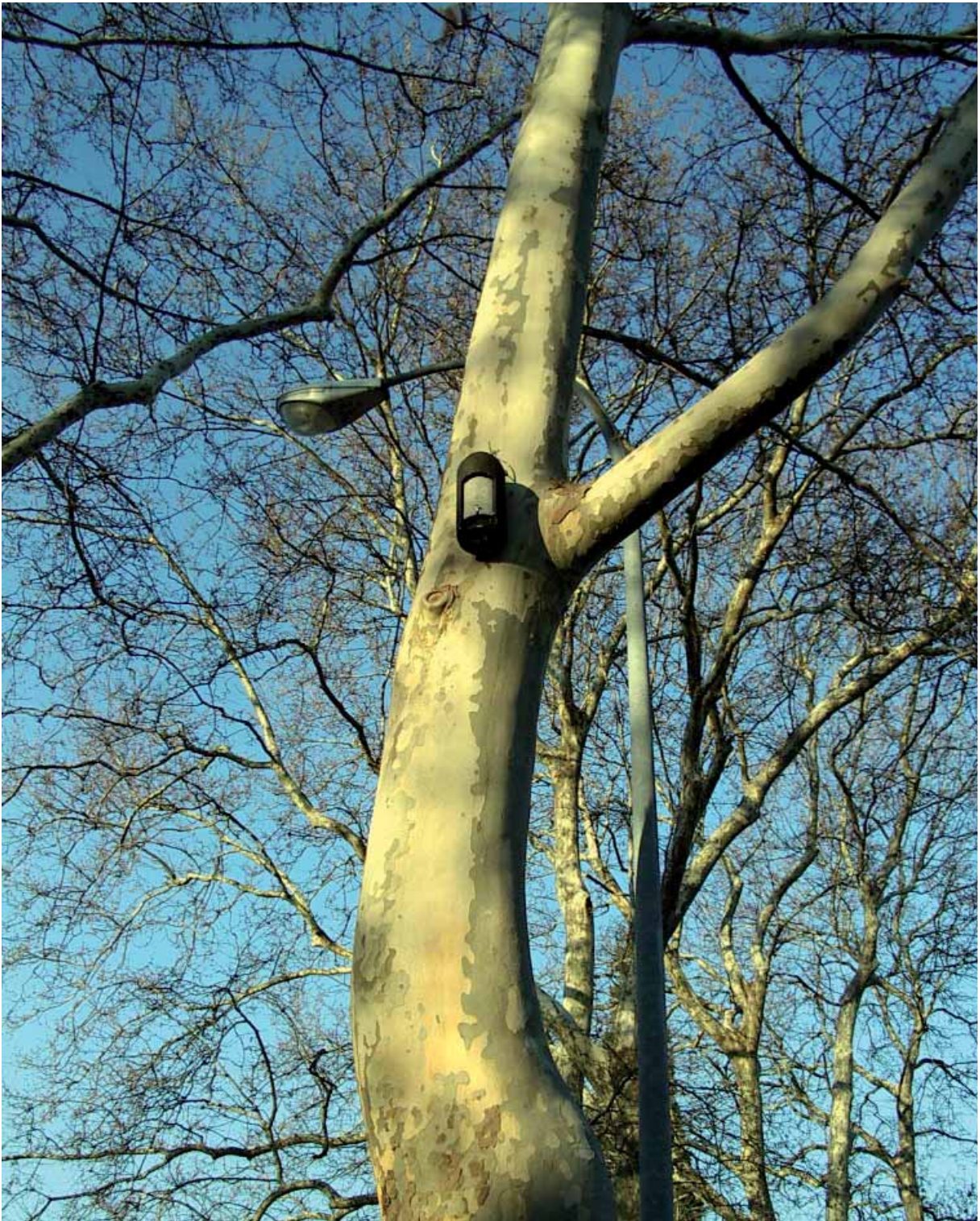
Nueva caja instalada.
