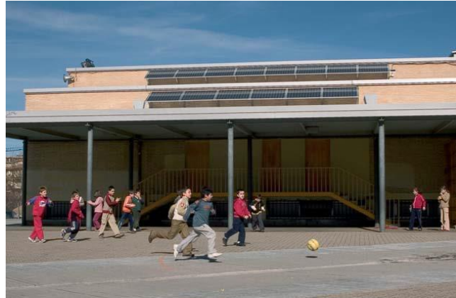
Ilustración 2 Tejado Fotovoltáico en Colegio Hegoalde (Fuente: AEMPA/SEV)
