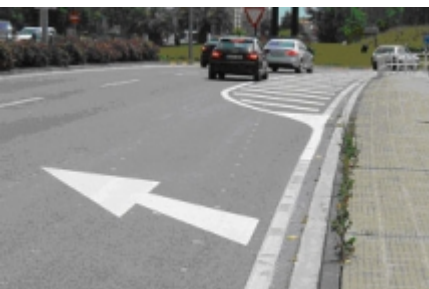
En la avenida de Navarra se eliminan un carril de acceso a la rotonda que llega a la calle Iñigo Arista
