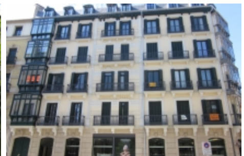
Rehabilitación de edificio en la calle Curia, 18
