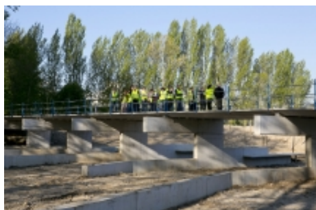
Visita de obra en abril al parque de Aranzadi
