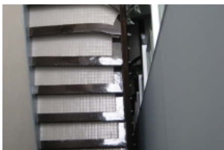
Detalle de la rehabilitación del edificio de la Plaza del Castillo 44
