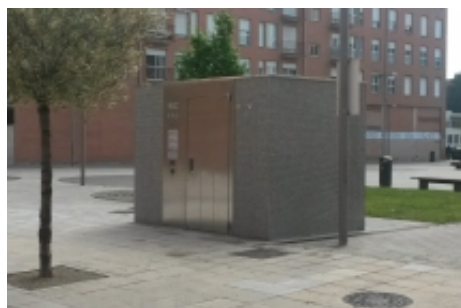
Se construye un nuevo aseo público autolimpiable en el paseo Sandúa
