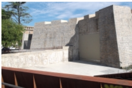
La restauración de las murallas incluye el mantenimiento de instalaciones y usos anteriores o la creación de otros nuevos
