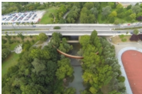
La nueva pasarela junto al puente de la avenida de Navarra será totalmente accesible y complementaria a la ya existente
