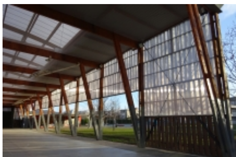
Se añade el cierre parcial de la fachada de la pista polideportiva del Colegio Público Mendillorri-Elorri
