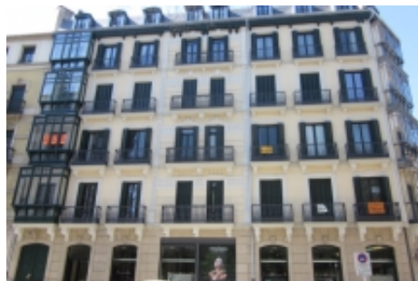
Rehabilitación de edificio en la calle Navas de Tolosa.
