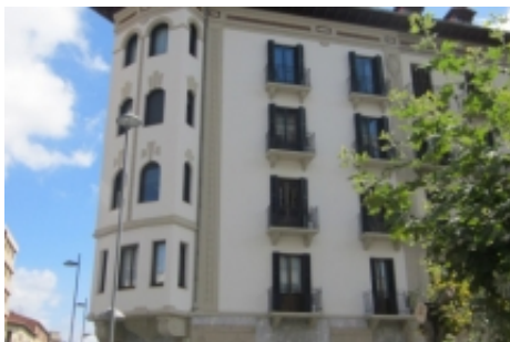
Rehabilitación de edificio en la avenida de Carlos III, 29.
