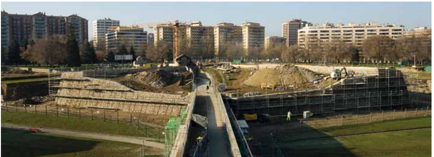
>Obras en el revellín de Santa Isabel.
